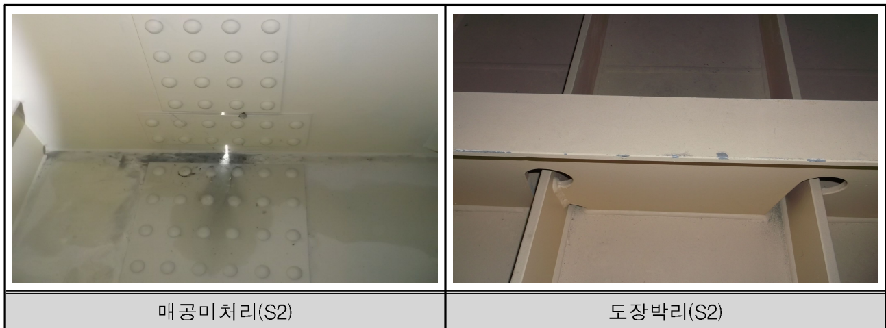
【표 3.1.2】 강 거더 및 가로보 외관조사 현황
