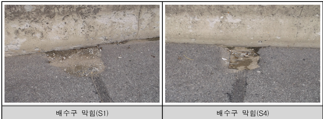
【표 3.1.10】 배수시설 외관조사 현황
