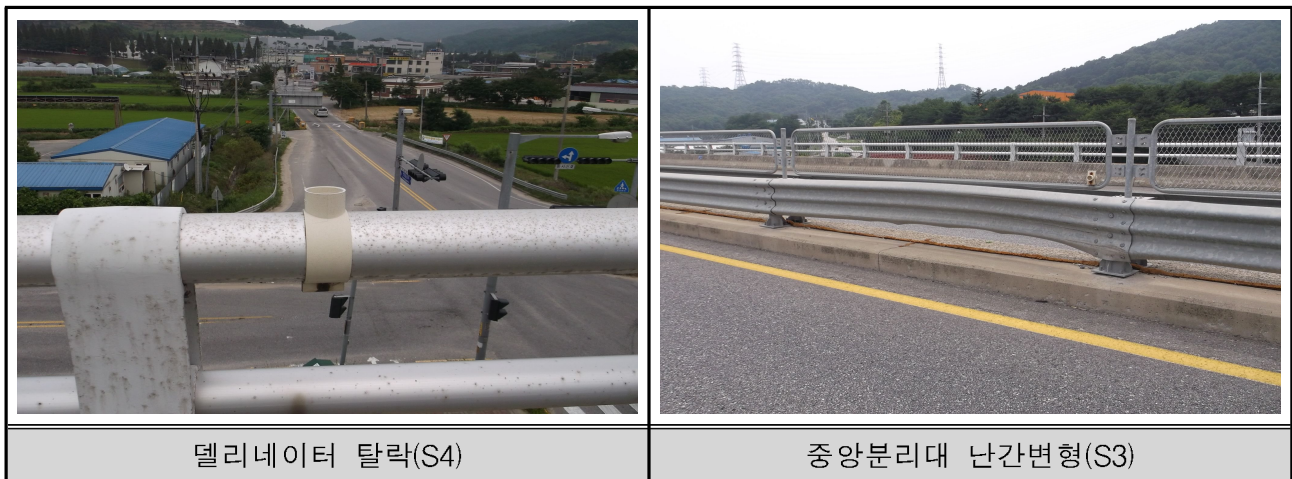
【표 3.1.9】 난간 및 연석, 보도부 외관조사 현황
